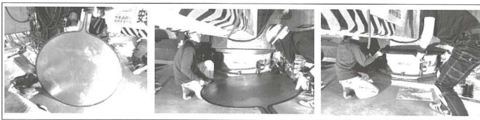
図 11 シートジャッキ設置作業状況
